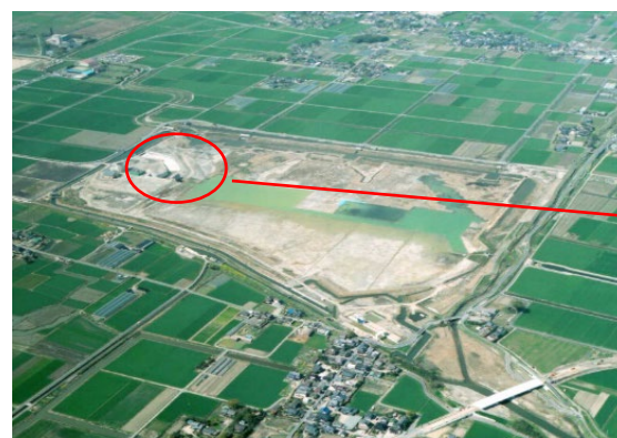
巨勢川調整池
