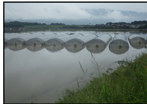
▼平成29年7月出水による内水浸水状況
