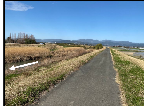
▼堤防整備状況(現況)※左岸1k000付近
