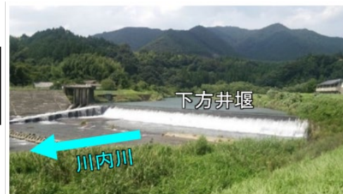
現況の下方井堰
