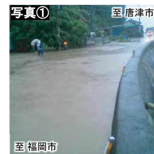
写真① 至 唐津市 ▲H22.7.13 道路冠水 （糸島市加布里地区）
