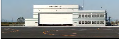
▲佐賀県防災航空センター
