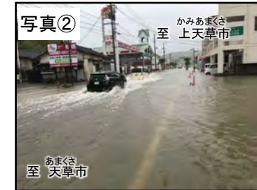
▲ 国道266号(現道)大雨による冠水
