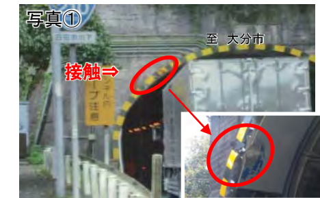
▲断面不足で坑口部へ接触
