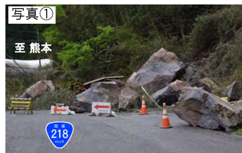
▲H28熊本地震 国道218号
