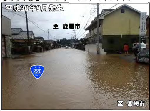
【写真①】大雨時の冠水(串間市)
