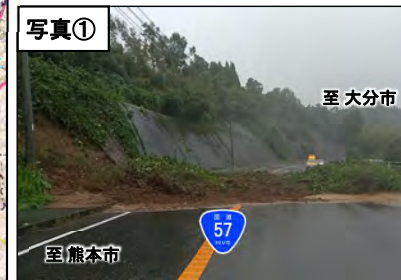
▲R4.9 台風14号の被災状況
