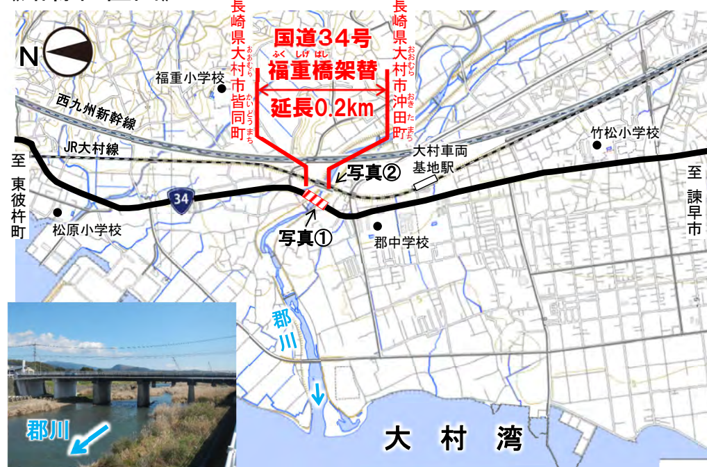
▲現況の福重橋の状況（全景）
