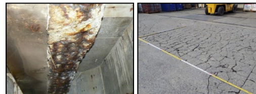
本港地区岸壁(水深7.5m)
