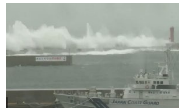
厳原地区 防波堤(北)
