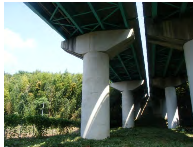
【橋脚補強(RC巻立て)】
