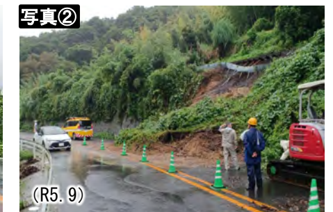
国道204号法面崩壊の状況（提供：長崎県）
