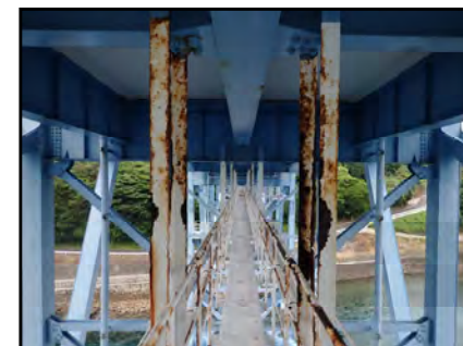
腐食状況(検査路)
