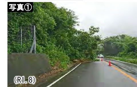
国道204号法面崩壊の状況（提供：長崎県）
