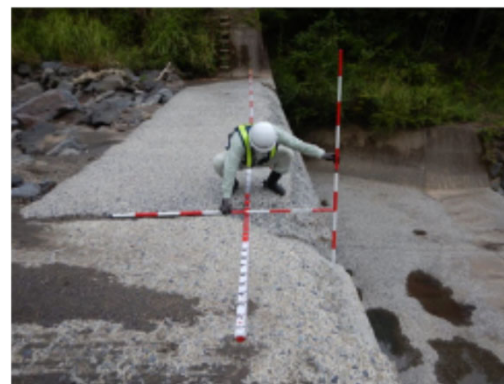
本堤水通し天端の摩耗・破損
