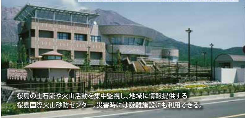
桜島国際火山砂防センター (鹿児島県鹿児島市野尻町)
