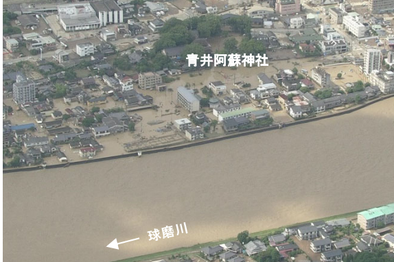
《浸水状況(人吉市青井地区)》
