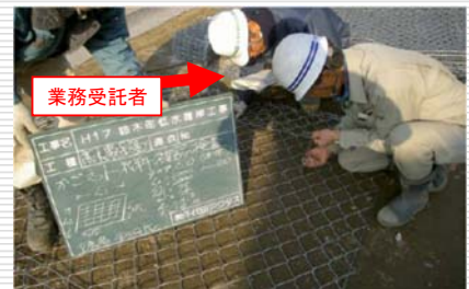
(河川護岸用かごマットの材料確認)
