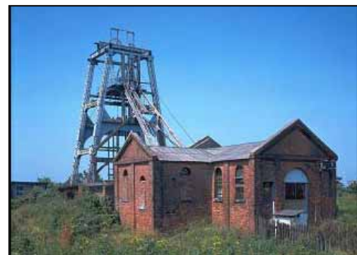
三池炭鉱宮原坑施設
