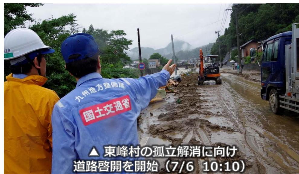
○ H29.7.6 (木) 福岡県からの要請を受け、東峰村へ繋がる国道211号の通行を確保するため、TEC-FORCEが被災箇所の復旧作業を進めています。
