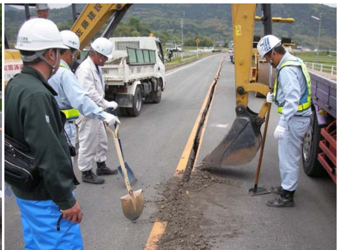
▲熊本河川国道事務所による工事監督支援
