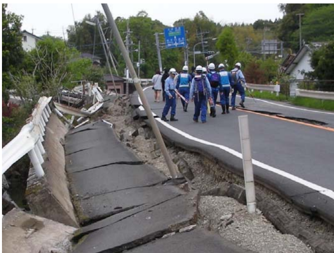
▲TEC-FORCE隊による現地調査
