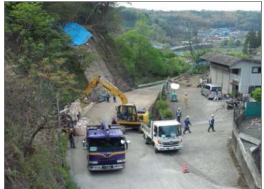
TEC-FORCEによる応急復旧作業状況
