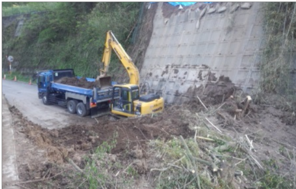
TEC-FORCEによる応急復旧作業状況
