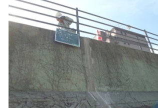
バラベット補修完了
