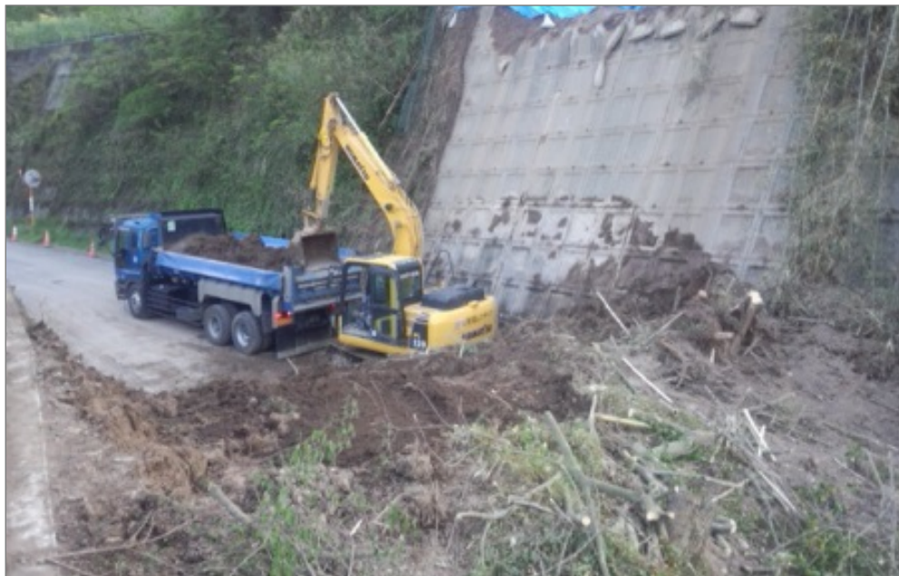
TEC-FORCEによる応急復旧作業状況
