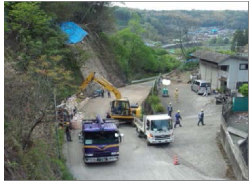
TEC-FORCEによる応急復旧作業状況
