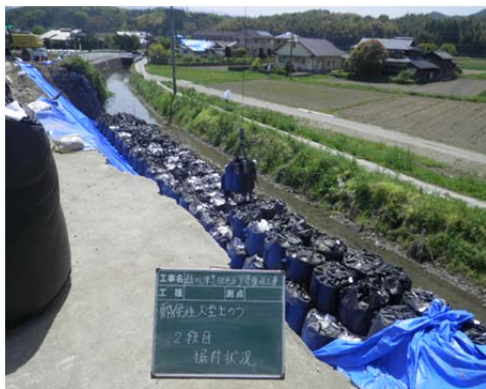
施工状況（昼間作業）
