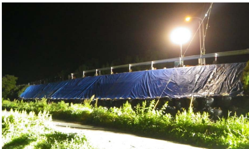
完了（平成 28 年 4 月 23 日撮影）
