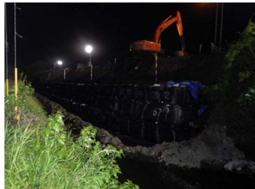
施工状況（夜間作業）
