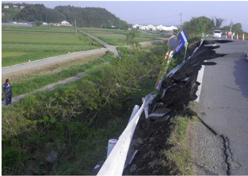
被災状況（平成 28 年 4 月 15 日撮影）
