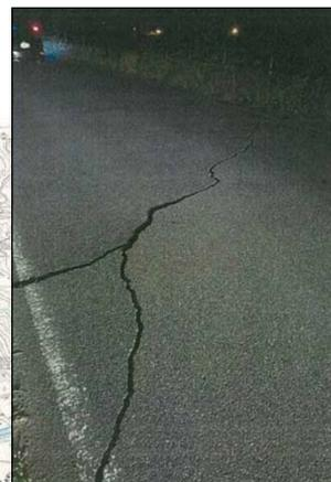
堤防天端の横断亀裂
