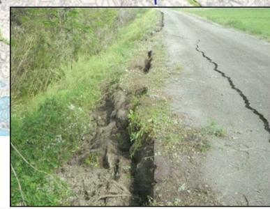
堤防天端の亀裂、法肩沈下
