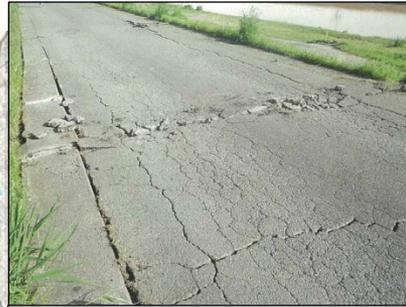
堤防天端の横断亀裂
