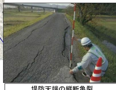
堤防天端の縦断亀裂
