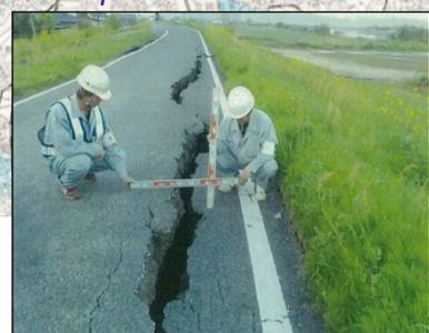
堤体の沈下（段差）
