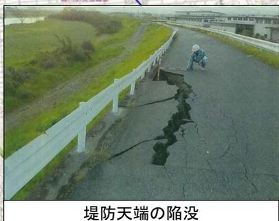
堤防天端の陥没
