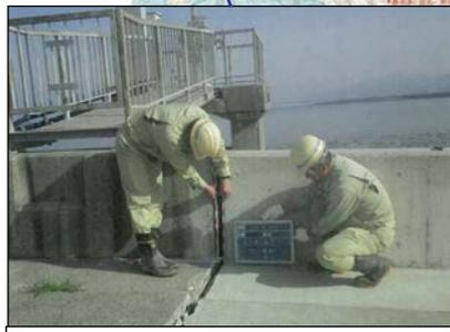
堤体の沈下（段差）
