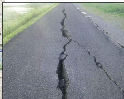
堤防天端の縦断亀裂
