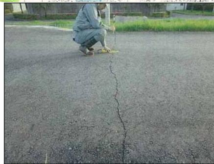
堤防天端の横断亀裂
