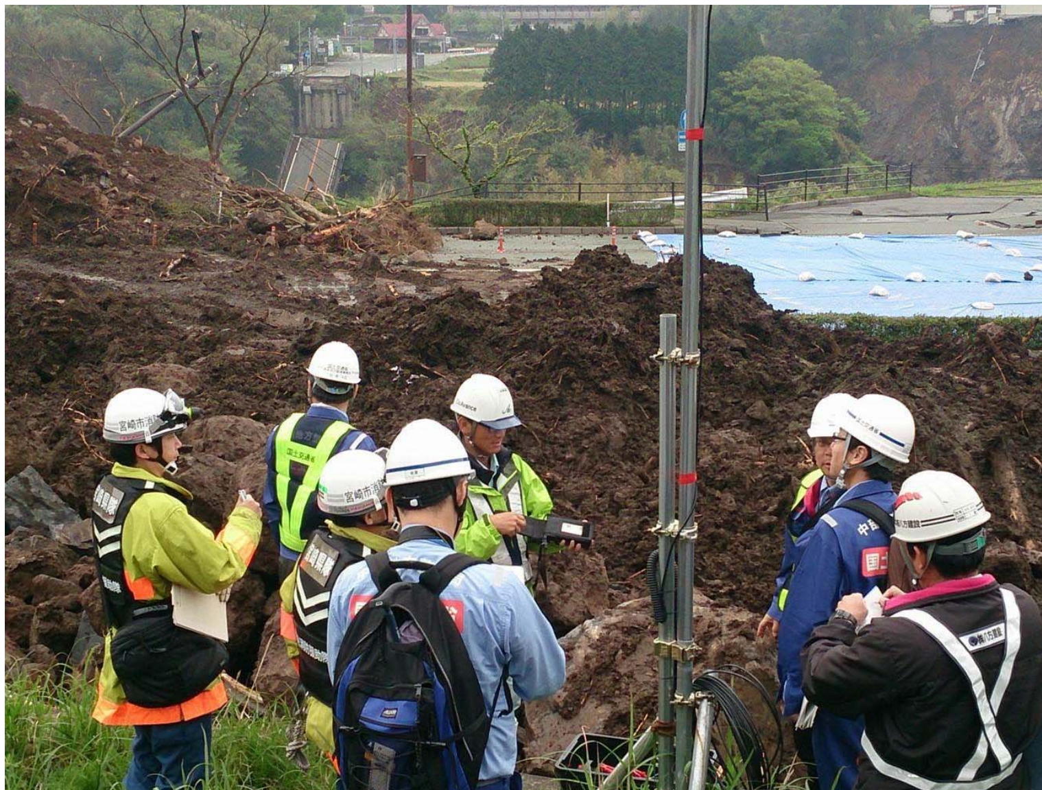
緊急消防援助隊との打合せ状況(4月24日)
