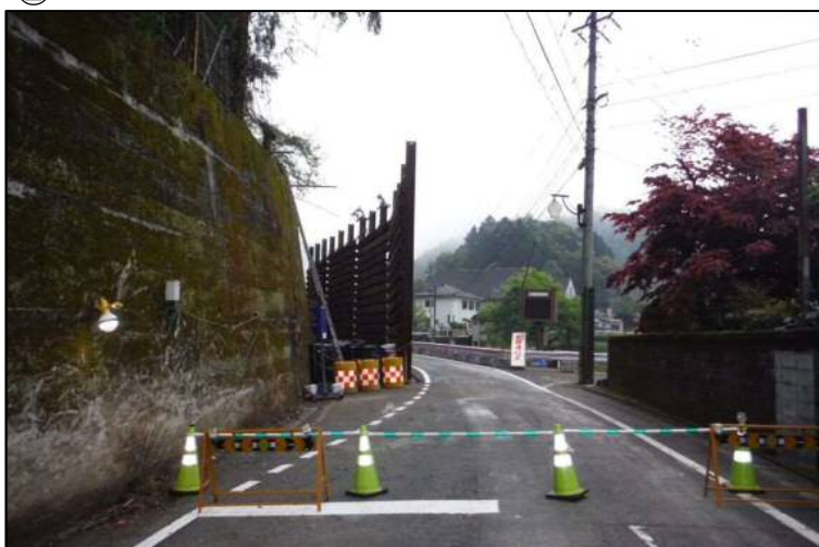
[応急復旧状況]
