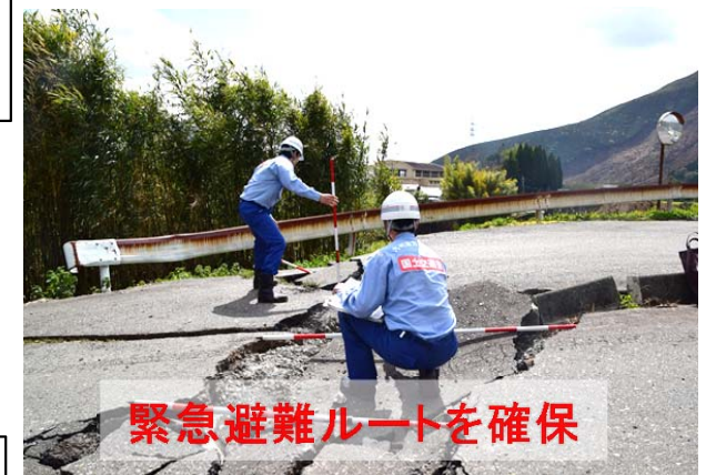
道路の緊急調査
