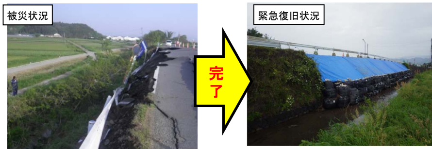
緊急災② 4/23 1:00完了 緑川左岸 20k700付近 (熊本市)
