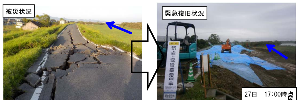
緊急災⑤ 緑川左岸 8k400付近 (熊本市)
