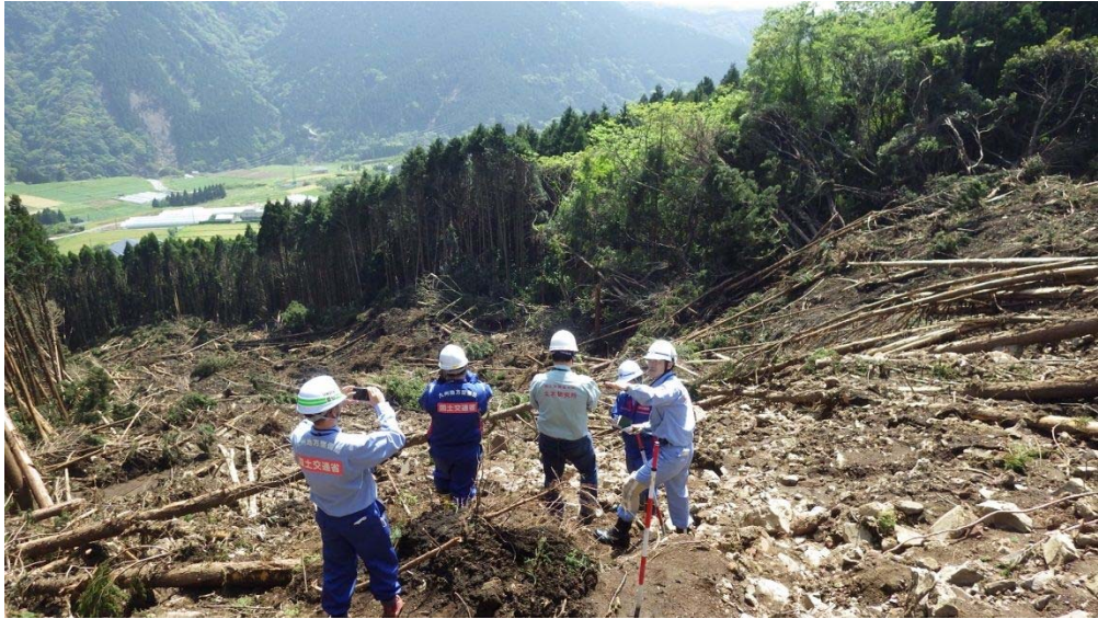
写真3 斜面崩壊の状況（上部より望む）
