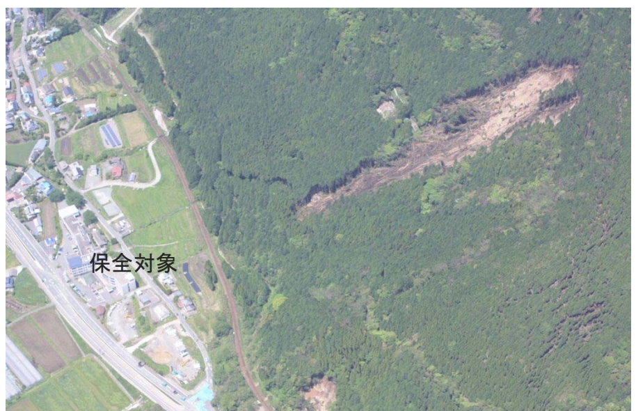
写真2 崩壊箇所を東側より撮影 (H28.5.4 はるかぜ号撮影)
