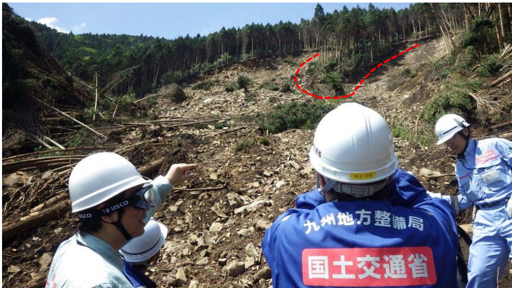
写真4 斜面上部の不安定土塊の状況（下部より望む）
