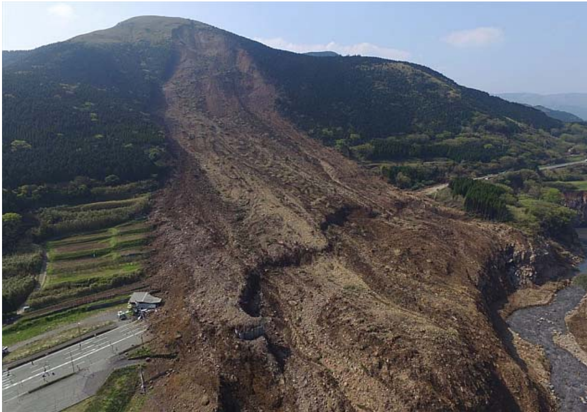
阿蘇大橋地区斜面崩壊(空撮)
