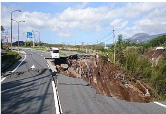
阿蘇大橋地区斜面崩壊(国道57号熊本側)
