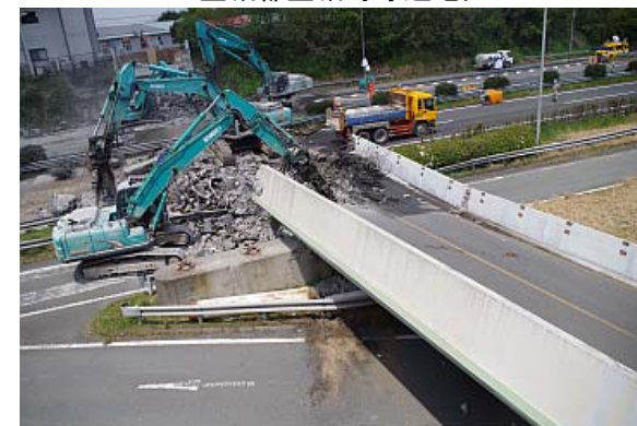
九州自動車道 緑川PA 府領第一橋落下 撤去作業
