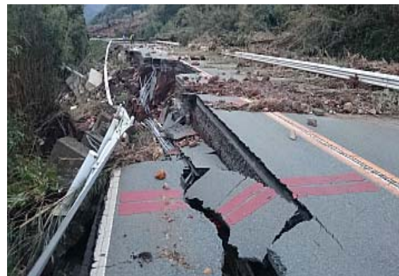
阿蘇大橋地区斜面崩壊(国道57号大分側)
