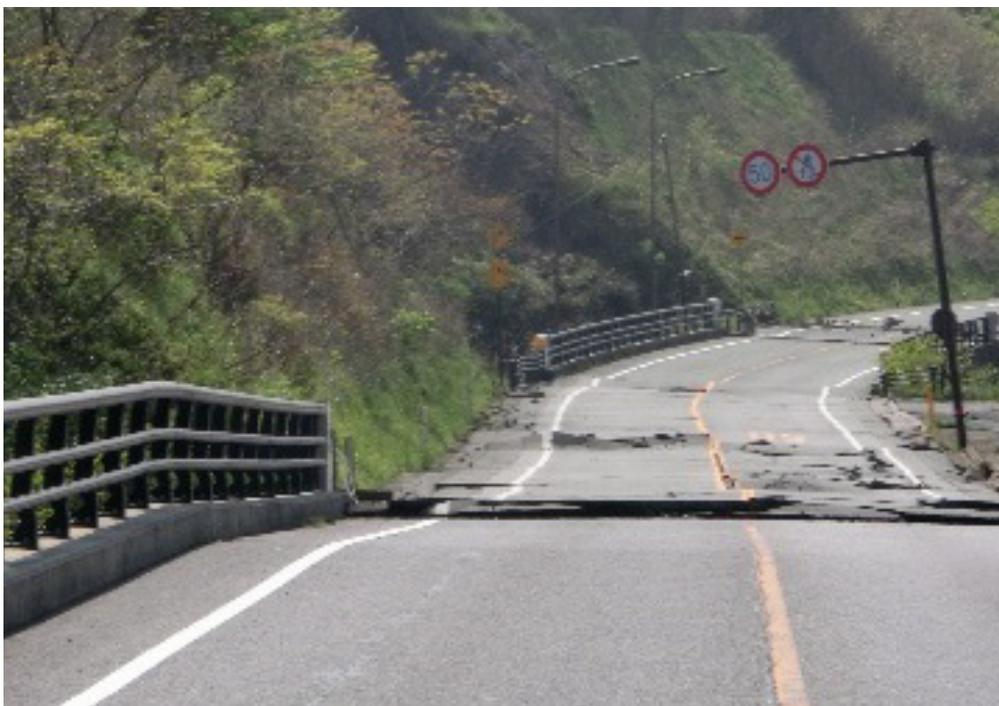
▲ 上部工の折曲り・橋台の沈下
