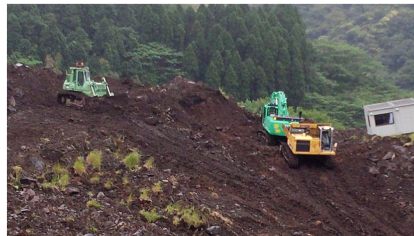
写真②無人化施工機械（バックホウ、ブルドーザ、不整地運搬車）による復旧状況
