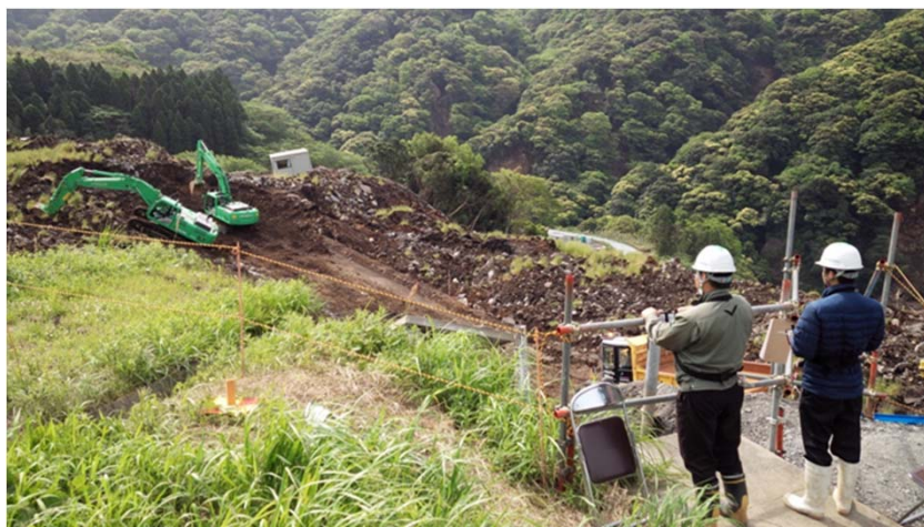
写真①遠隔操作状況
