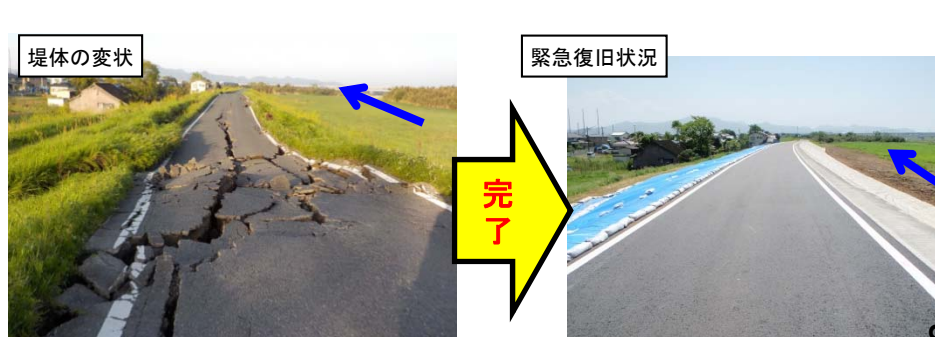
緊急災⑤ 5/1完了 緑川左岸 8k400付近 (熊本市)
