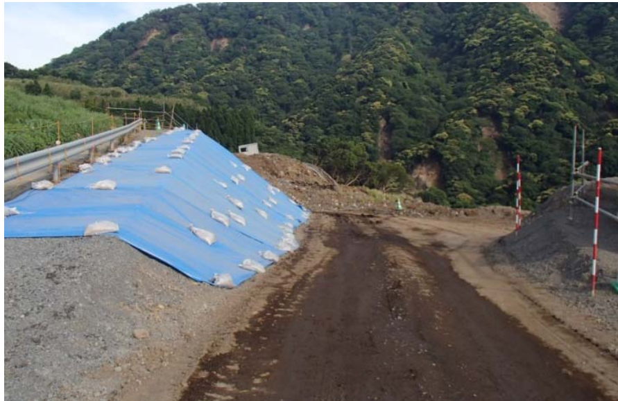
アプローチ道路の復旧状況 (5月27日)
