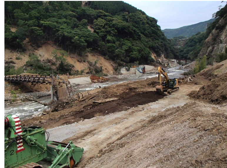
土砂の撤去・整地状況 (5月27日)
