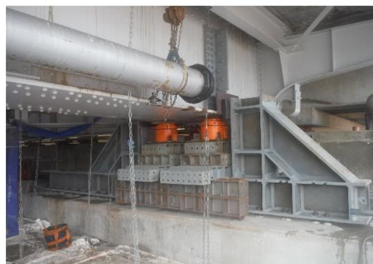
●橋の継ぎ目となる伸縮装置の損傷状況
