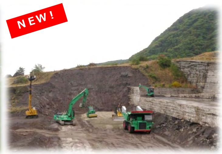
NEW! 砂防事業 (無人化施工)：水無川 (長崎県)
