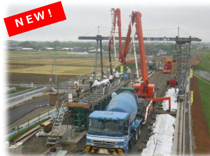
NEW! 橋梁工事：南九州西回り自動車道 (鹿児島県)
