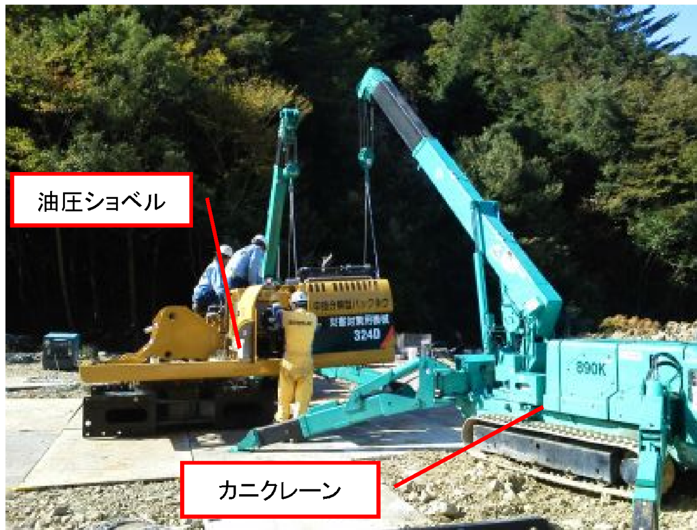
分解型BH組立状況 施工事例(近畿地方整備局)
