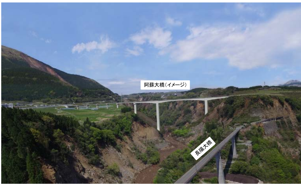
橋梁形式：PC 3径間連続ラーメン箱桁橋
