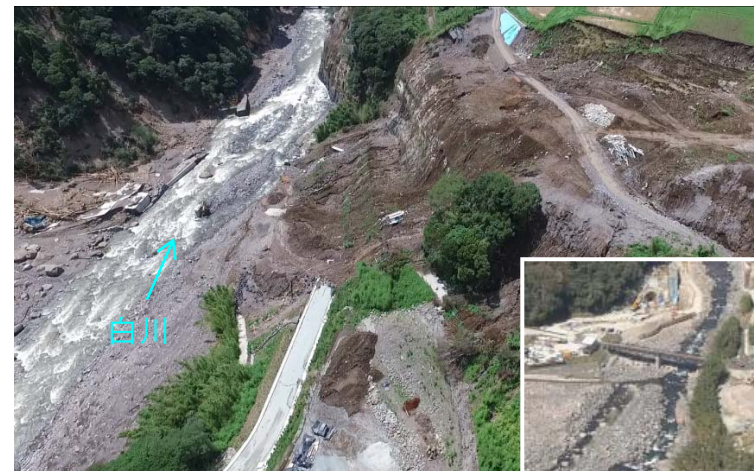
貯水地法面崩落・仮橋落橋状況(H28.7)
