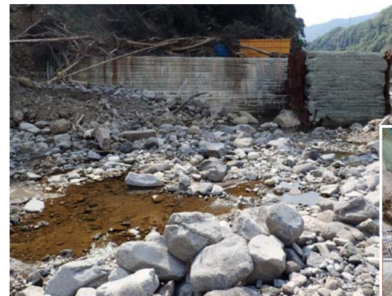
仮排水路トンネルの土砂埋塞(H28.7)
