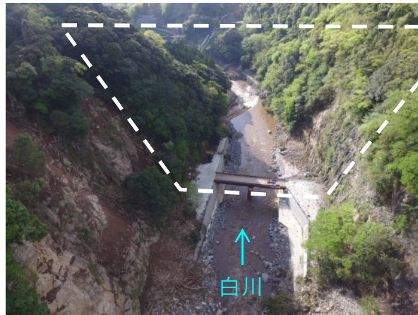
ダム建設予定地付近の状況(H28.5)
