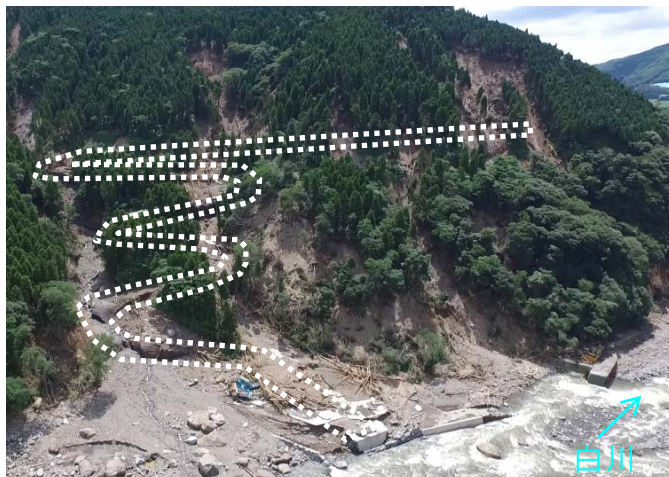
貯水地法面崩落・工事用道路埋没(H28.7)
