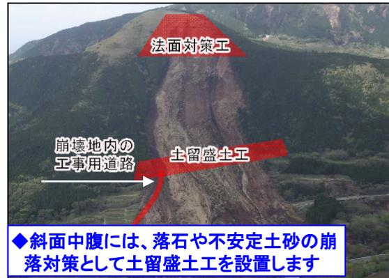
◆斜面中腹には、落石や不安定土砂の崩落対策として土留盛土工を設置します
