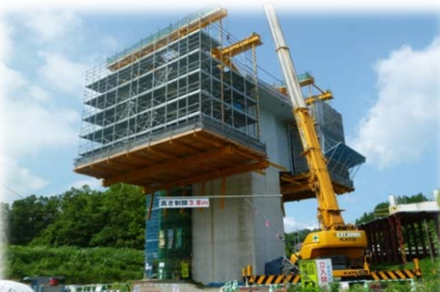
橋梁工事：大野竹田道路（大分県）
