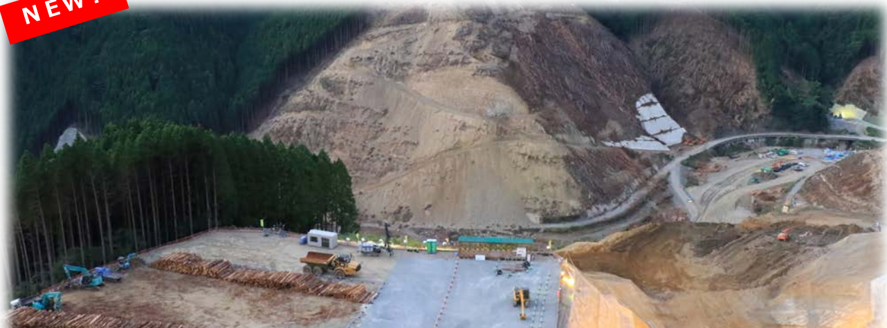
ダム工事：小石原川ダム（福岡県）
