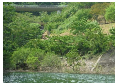
対策工事例②(Bダム)
