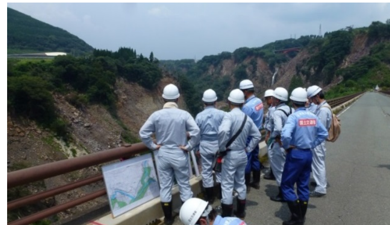
現地調査状況 (H28. 8. 3)
