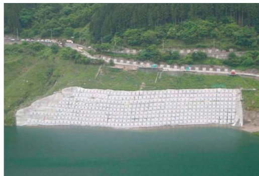
対策工事例①(Aダム)
