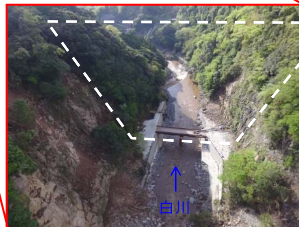
ダム建設予定地付近の状況 (H28.5)
