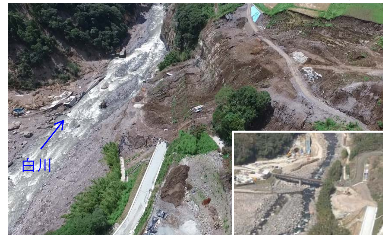
工事用道路埋没・仮橋落橋状況 (H28.7)
