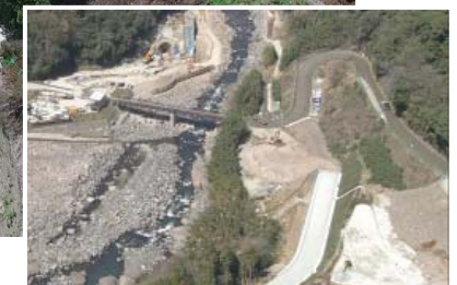
地震前の状況 (H28.3)
