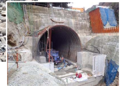
地震前の状況 (H28.2)
