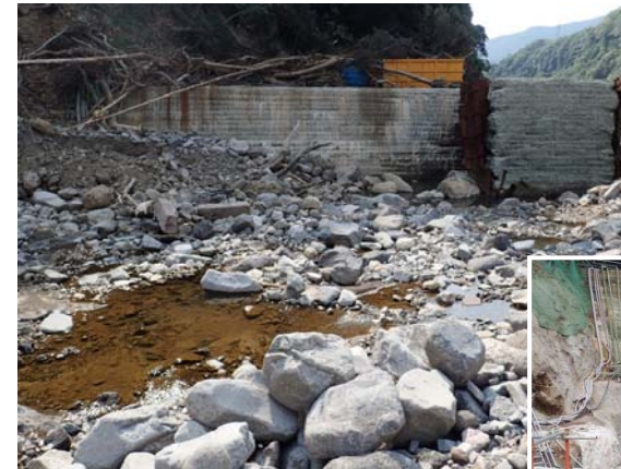
仮排水路トンネルの土砂埋塞 (H28.7)
