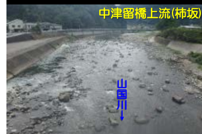
ダム補給後の河川状況(H28.8.24)
