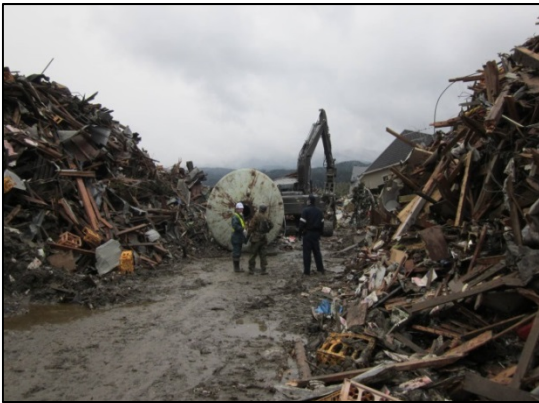
災害協定協力会社・自衛隊等の協力を得て 道路啓開作業を実施 (平成 23 年 3 月 東日本大震災時)
