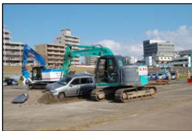
【道路啓開訓練イメージ】
