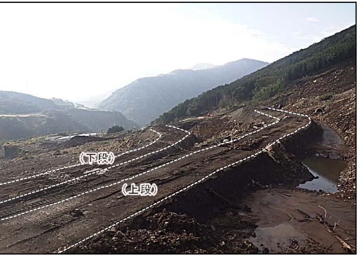
土留盛土整備状況(10月30日大分側より撮影)
