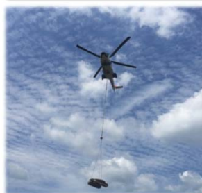
▲分解した重機をヘリで空輸し、頭部で組立
