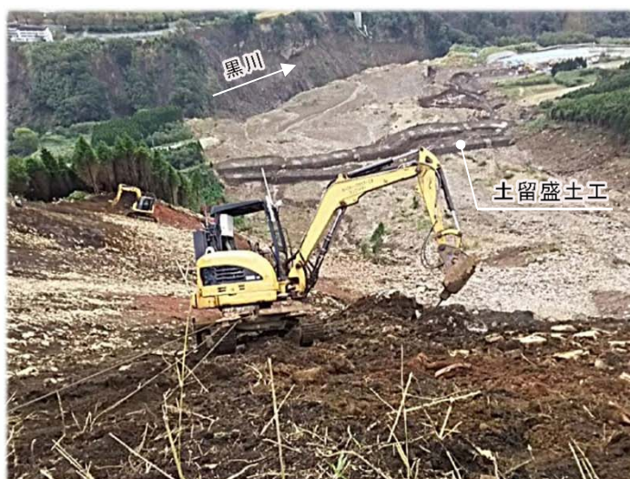
▲不安定土砂の除去[10月31日撮影]
