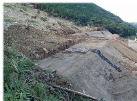
▲8月末、土留盛土の上段が完成
