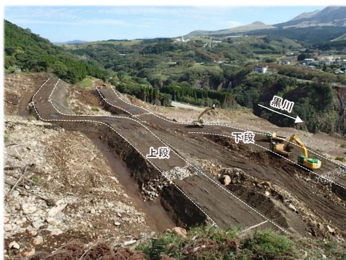
▲土留盛土[10月31日撮影]
