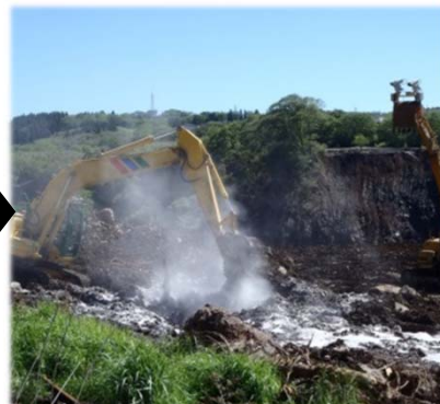
▲土砂を改良しながら施工
