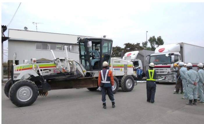
グレーダーによる放置車両牽引訓練
