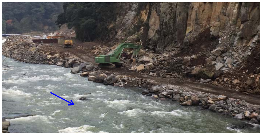
左岸工事用道路 (河床部) の復旧状況
