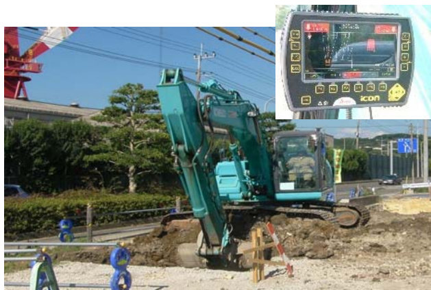
マシンコントロールによる施工
