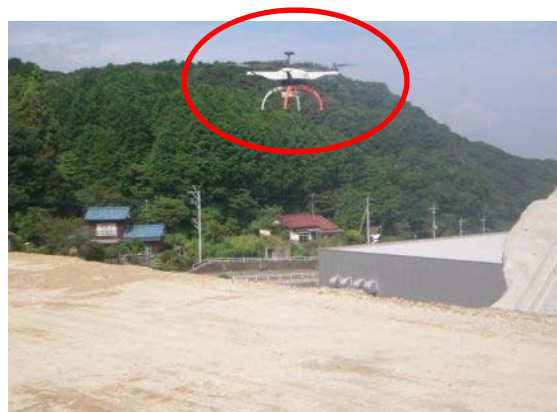
UAVによる測量
