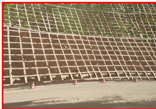
土砂撤去後の既設舗装及び法枠工の状況
