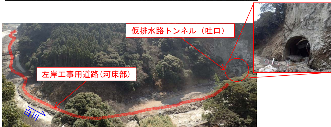
左岸工事用道路(河床部)及び仮排水路トンネル(吐口)の状況
