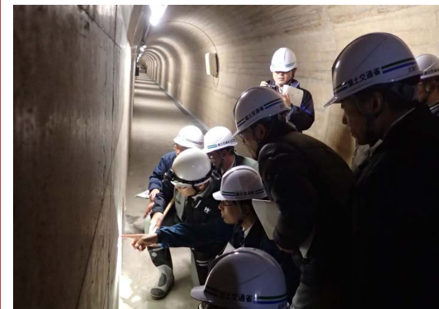
巖木ダム総合点検現地検討会の現場研修
