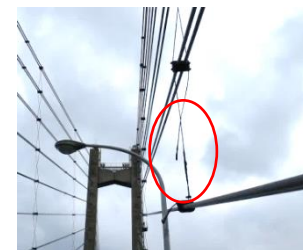
制振ワイヤの破断
