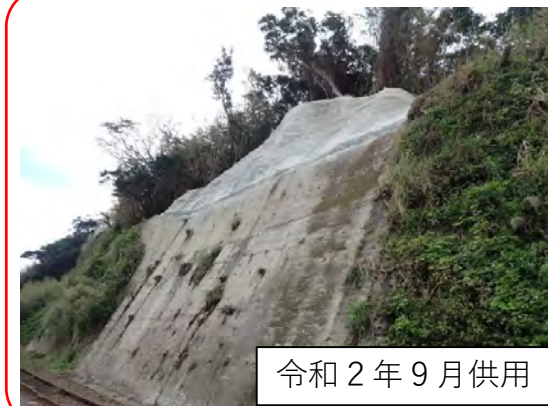
法面对策を実施した結果、被害なし (令和 3 年 8 月豪雨)
