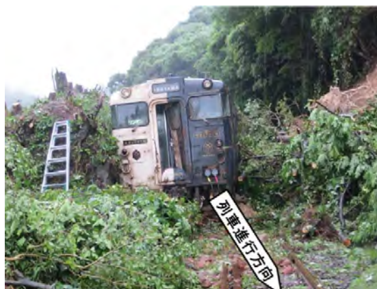
線路脇の斜面が崩壊し、列車が脱線 (平成 2 6 年 6 月豪雨)
