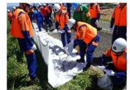
消防団による水防工法
