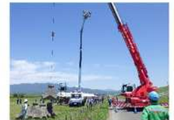
決壊箇所応急復旧訓練
