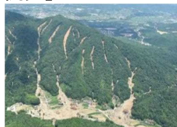
同時多発的な表層崩壊や土石流
