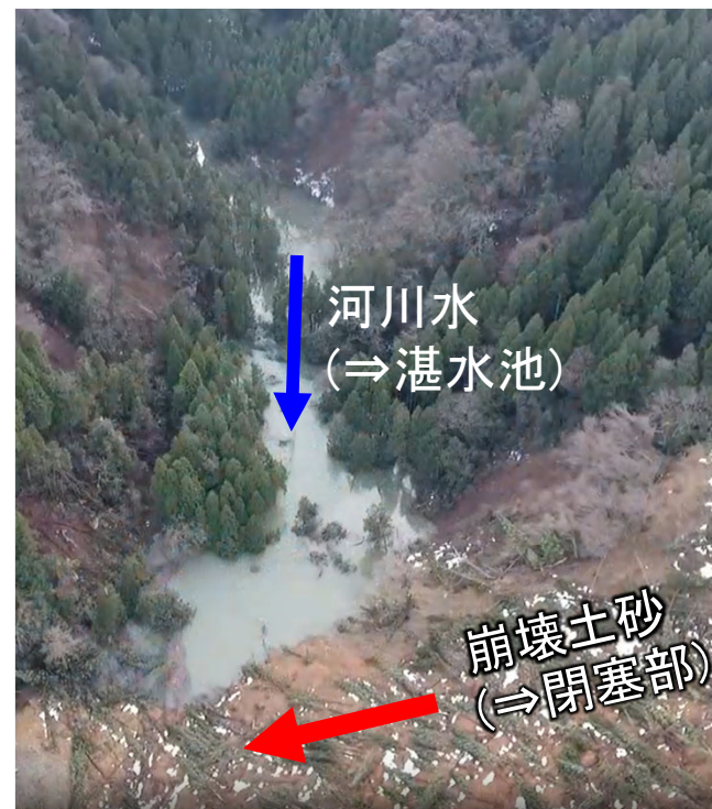
河道閉塞（土砂ダム）の事例 （令和6年能登半島地震）
