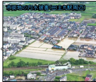
▲R5.7洪水における浸水被害状況
