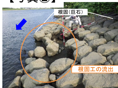
(根固工被災状況: 下流側)
