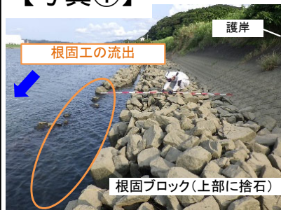
(根固工被災状況: 上流側)
