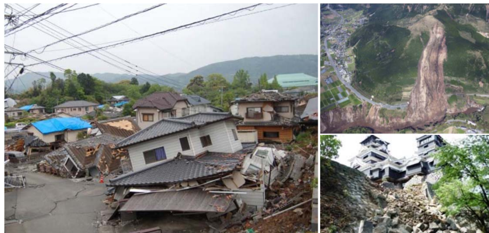
熊本地震による被災状況、上: 益城町、右上: 南阿蘇村、右下: 熊本城 出典: 九州地方整備局、熊本市HP
