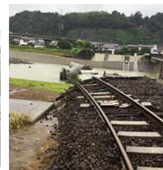
流出した久大本線「花月川橋梁」。18年夏を目処に復旧を進めている。
