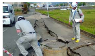
福岡市による下水道施設の被災状況調査
