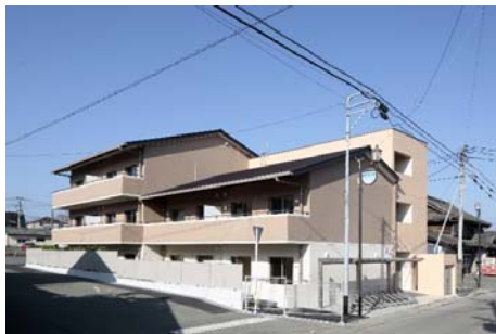
竣工した竹田市の住宅
