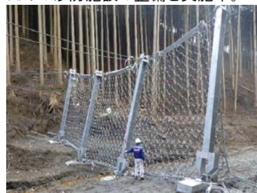
強靱ワイヤーネット工の設置
