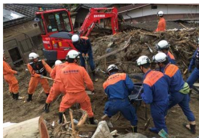
瓦礫・土砂の除去作業支援
