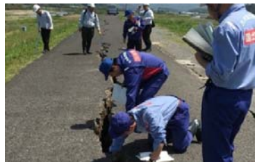
TEC-FORCEによる被災地の施設調査
