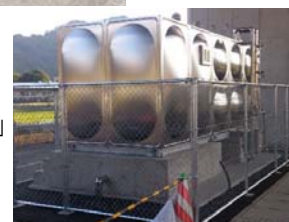
道の駅「田浦」 (熊本県)の 貯水槽
